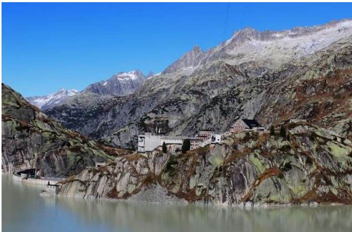
En primer terme i a l'esquerra, el llac Grimsel i el mur de contenció de la presa. Al centre, la central hidroelèctrica i l'hotel Grimsel Hospiz. Foto: Paulí Gispert. Any 2017.
