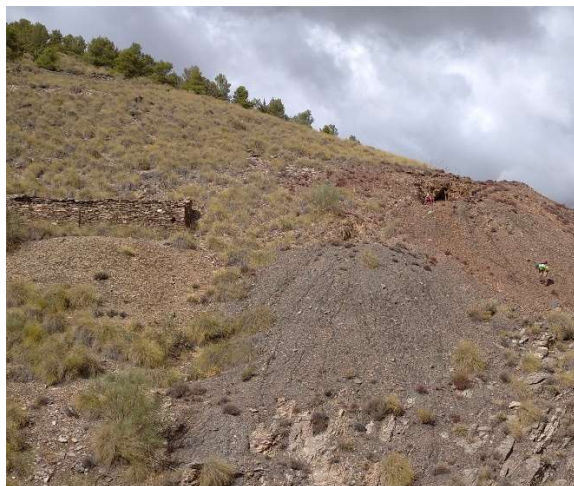
Fig. 2. Escombrera de la mina
