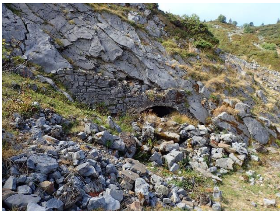
11- Boca d'entrada de la galeria principal que donava a la plaça de maniobres de la mina, entre els dos terregalls.
