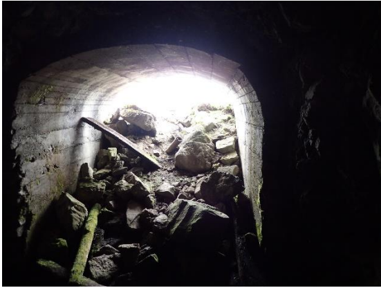
15- La boca d'entrada de la galeria principal vista des de dins. La volta i parets del primer tram estan reforçats amb formigó. Es pot veure com l'entrada s'ha anat reomplint, però es pot passar sense gaire dificultat.
