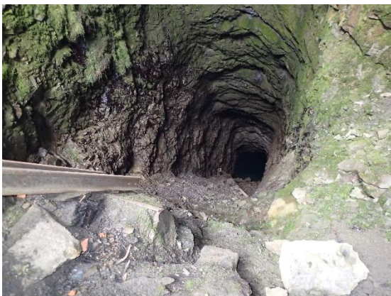
19- ...que comunica amb alguna galeria inferior amb una trajectòria gairebé vertical i que devia servir per a treure el mineral. En aquest punt cal anar amb precaució; no val a badar.
