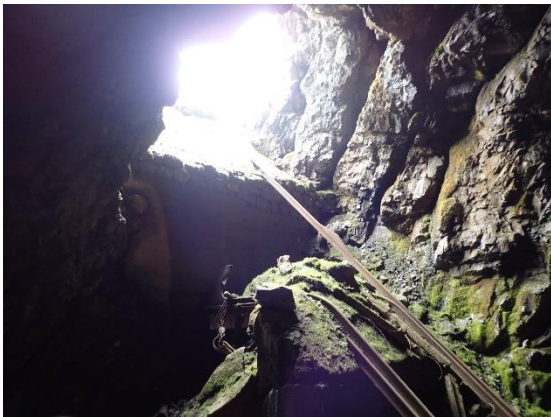
17- Pla inclinat amb restes de rails que comunica amb l'exterior just per sobre i a l'esquerra de la boca per on hem entrat.
